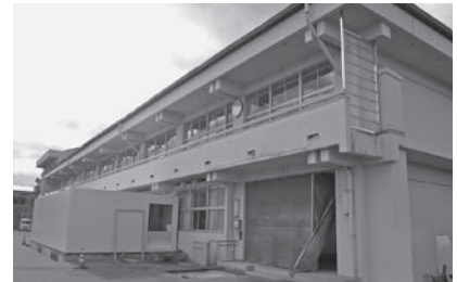
改修工事中の旧大蛇小学校
