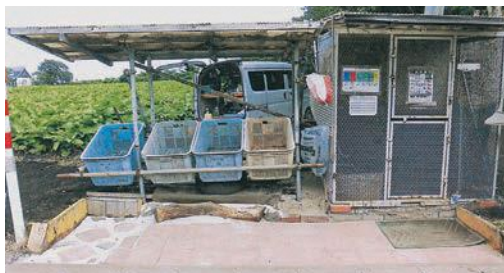
平板と砂を敷き詰めて整備したゴミステーション
