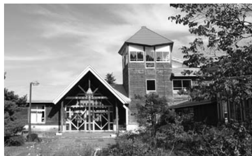
階上小学校校舎 外壁屋根塗装工事 1,683万円
