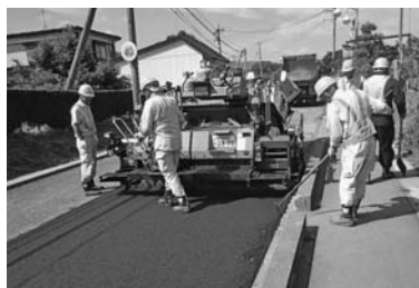
道路工事の様子
