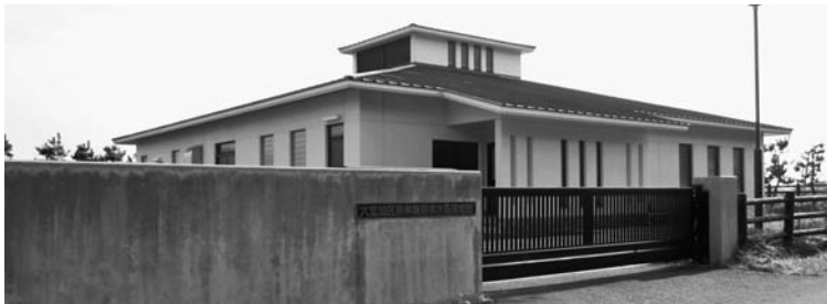
大蛇地区漁業集落排水処理施設
