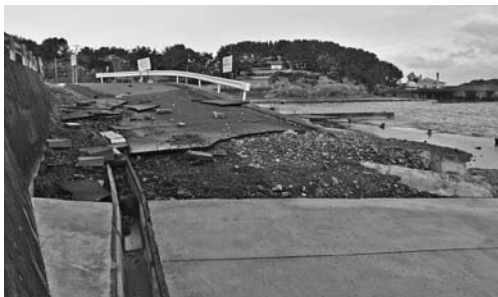
漁港施設災害復旧工事 635万円
