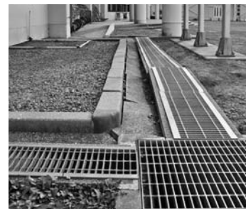
赤保内小学校外構補修工事 410万円
