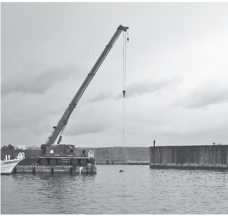
転石撤去工事の状況
