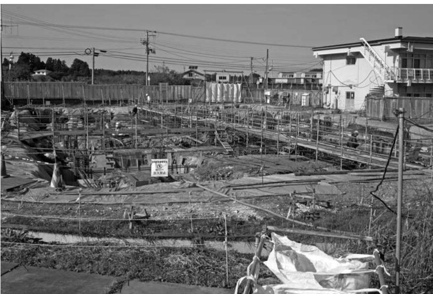
平成28年3月の完成に向けて工事中の道仏コミュニティセンター（仮称）建設地
