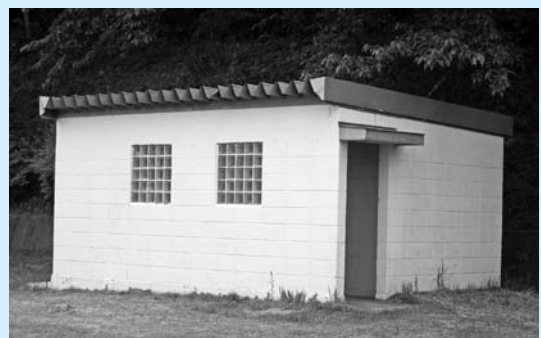
改修される外トイレ
