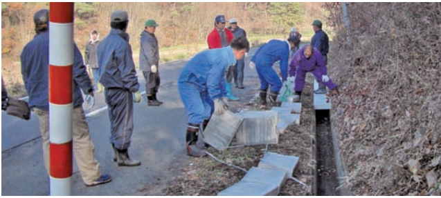
道路側溝の蓋を整備する地区住民
