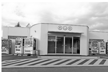
道の駅トイレ
