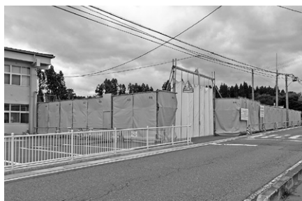
道仏体育館解体工事
