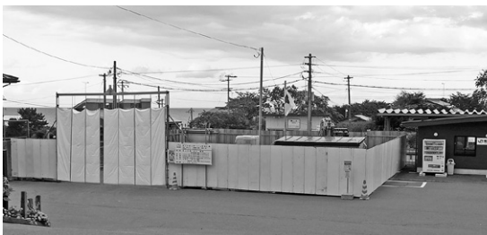
階上駅前公衆トイレ新築工事
