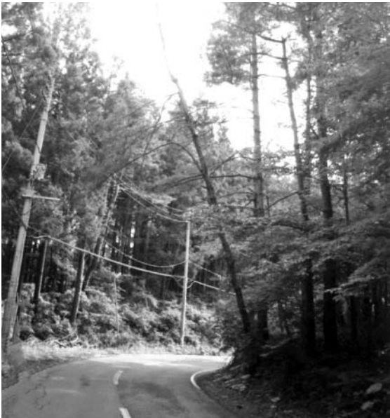
道路上に傾いている樹木
