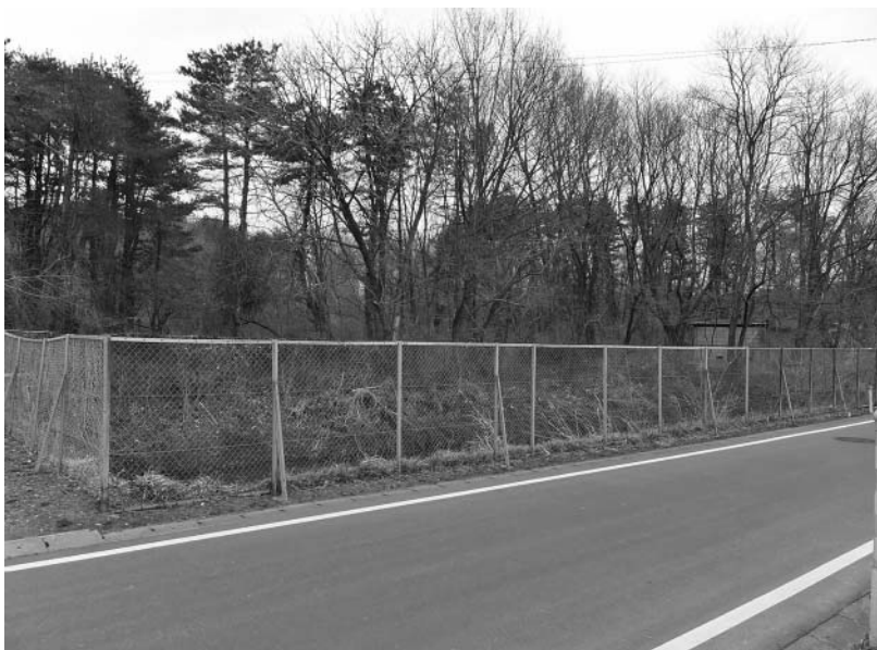
調整池は安全のためフェンスで囲まれている
