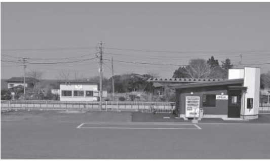
階上駅 公衆トイレ新設 2,805万円
