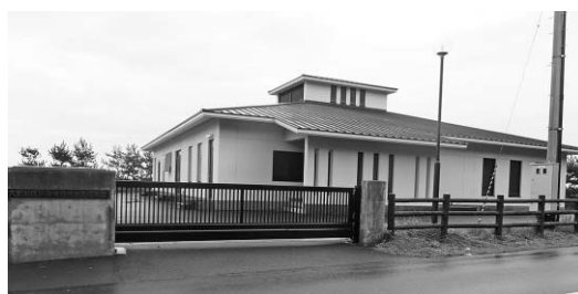
漁業集落排水処理施設
