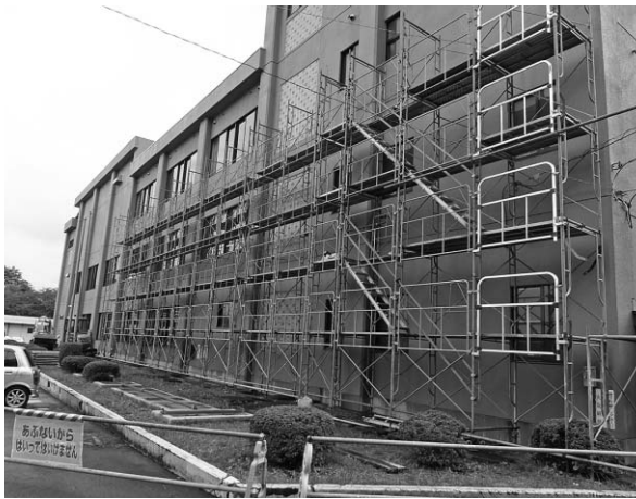
耐震補強・改修工事のはじまった役場庁舎
