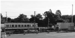
工事がすすむ階上駅
