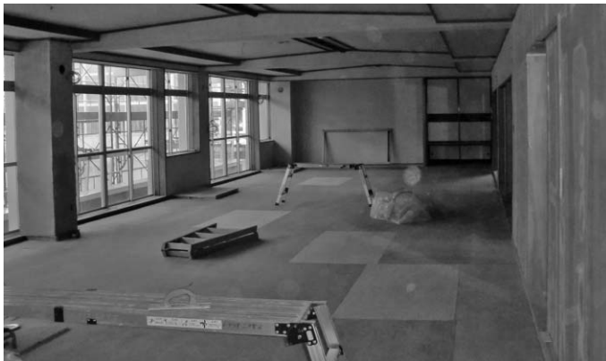
道仏公民館耐震補強・改修工事の進捗状況
