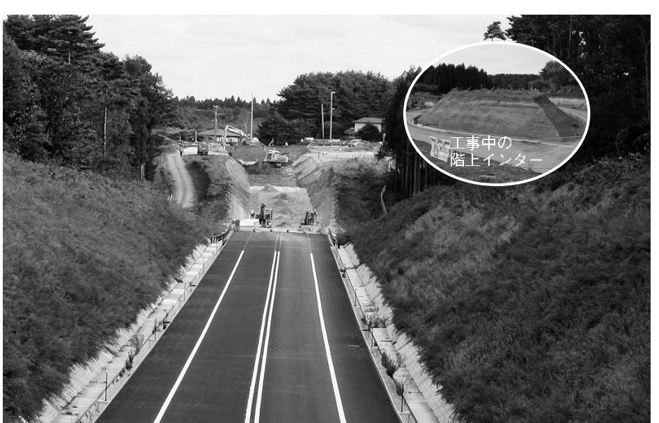
階上インターへ続く道路工事
