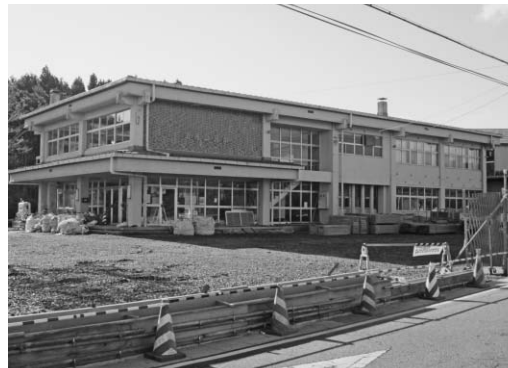
耐震補強・改修する道仏公民館
