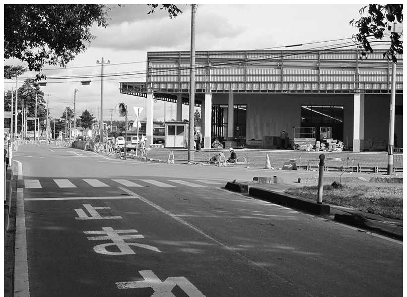
建設中ホームセンターの周辺道路（役場前～耳ヶ吠線）
