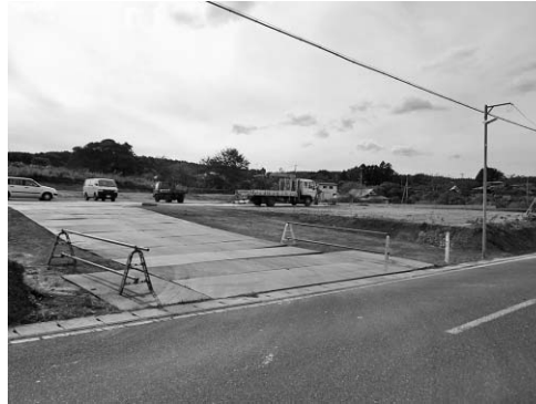
整地が完了した大蛇地区集会所移転新築現場
