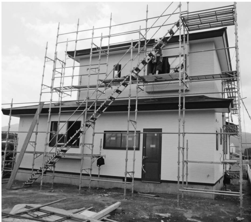
建設中の新築住宅（7月上旬撮影）
