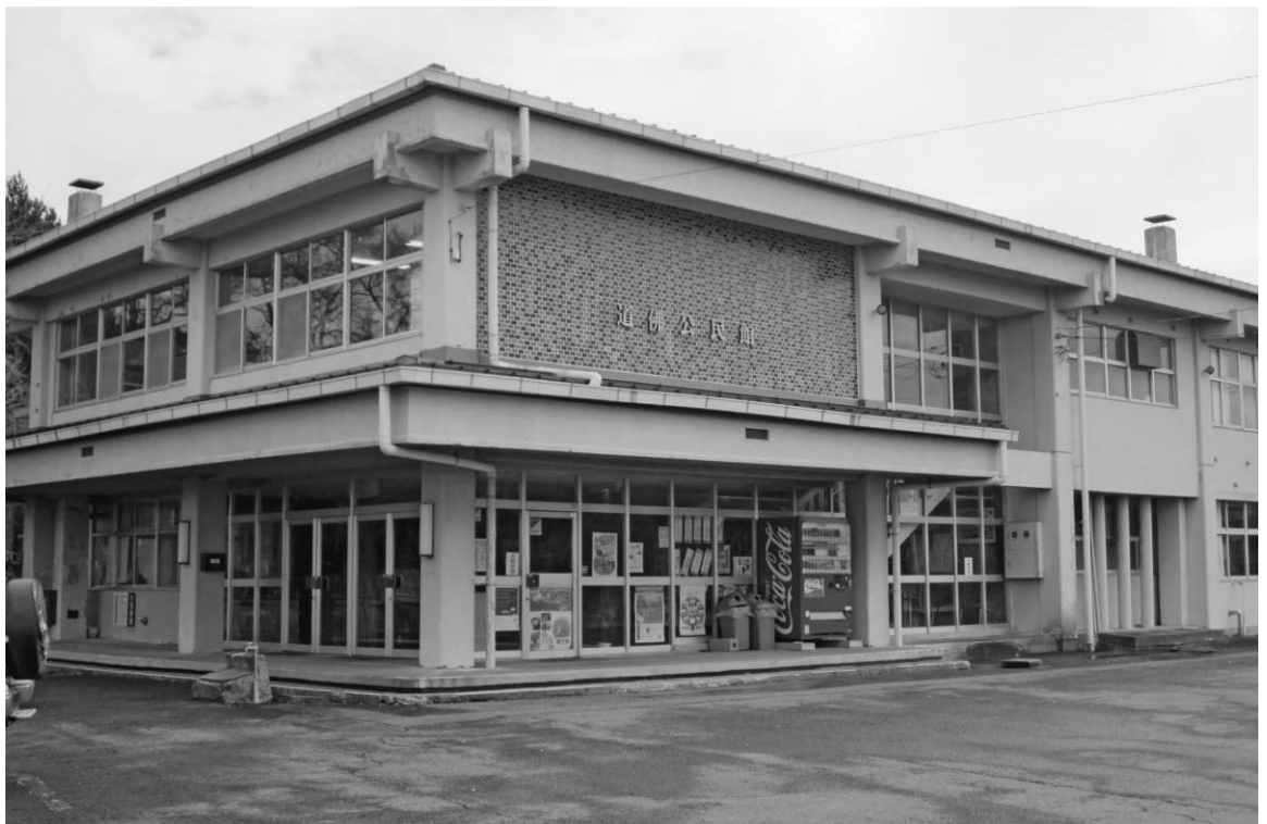
耐震補強・改修をする道仏公民館
