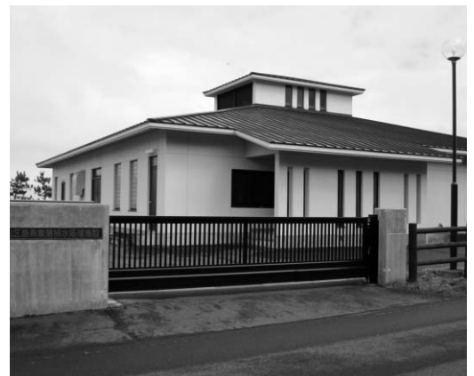
復旧した大蛇地区漁業集落排水処理場
