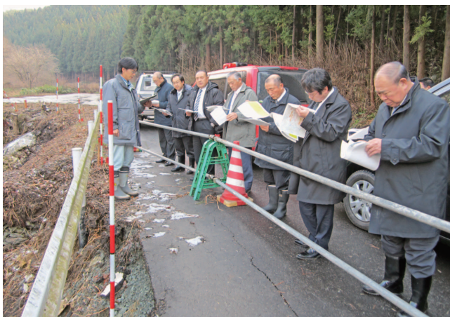
芦間沢川の被災現場
