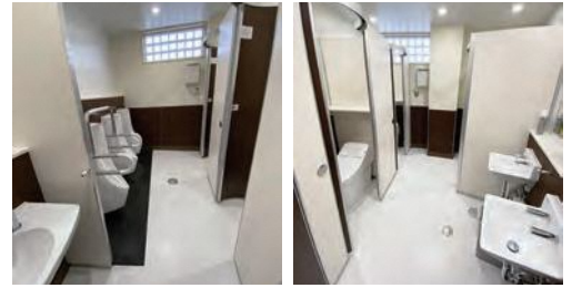
工事が完了した男性用トイレ（左）と女性用トイレ
