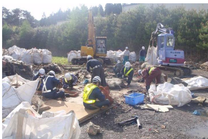
▲ガレキの処理を行う作業員（榊地区）
