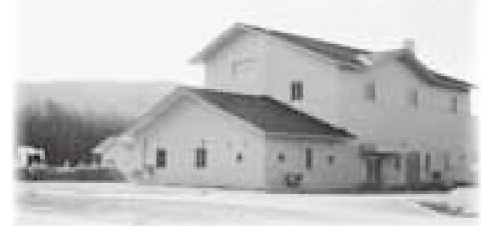
茨島浄化センター
