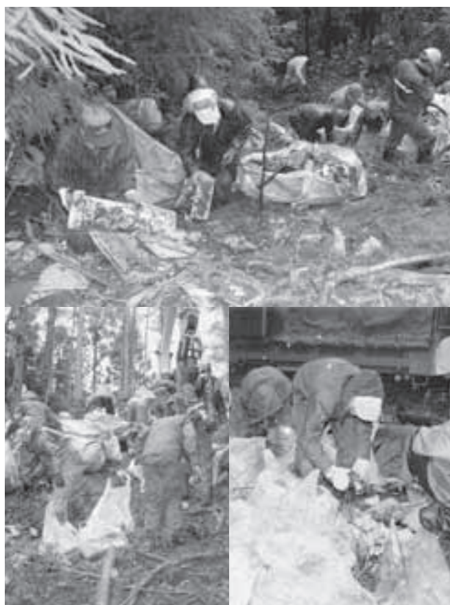
撤去作業の様子。
