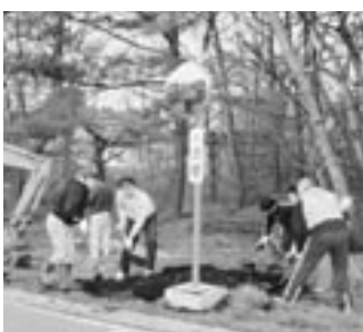
設置作業に汗を流すPTA、地区民ら
