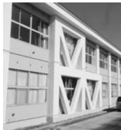
耐震補強工事 後の校舎 (階上中学校)
