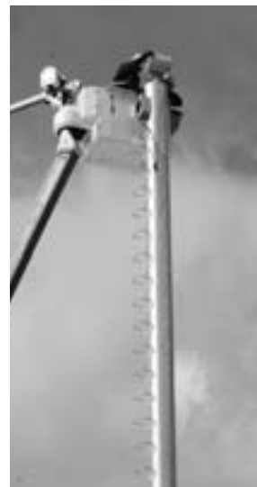
監視カメラ設置工事の様子
