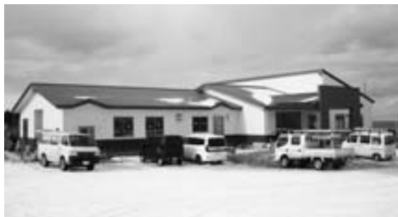
大蛇駅向かい側に建設が進む大蛇地区集会所
