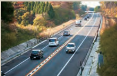
八戸南道路が全線開通(平成25年)
