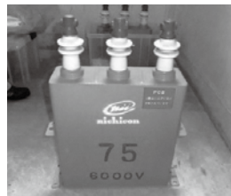
電力用 コンデンサー
