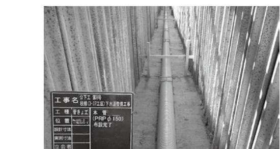
工事名 公下工 新設 規模 〇-〇(工区) 下水道事業工事 工種 管工 本管 (PRPφ150) 布設完了 位置 〇-〇(工区) 設計寸法 実測寸法 立会者
