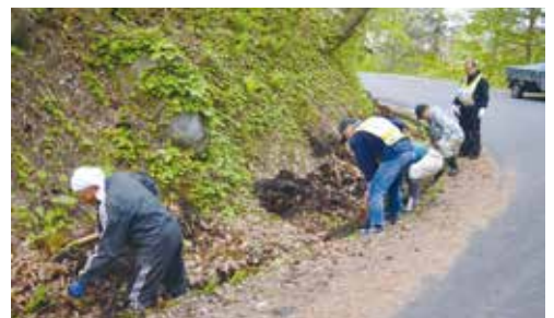
(写真) 側溝を清掃する様子
