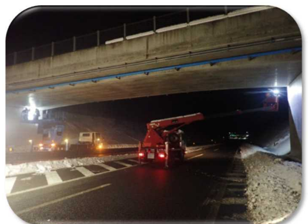
天当跨道橋点検状況 【高所作業車による点検】
