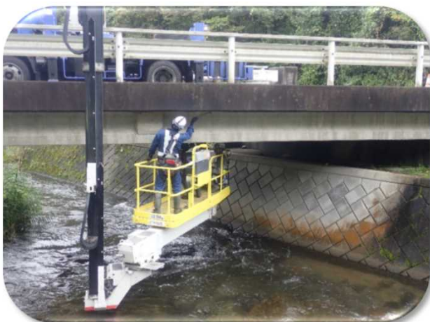
向第二橋点検状況 【橋梁点検車による点検】
