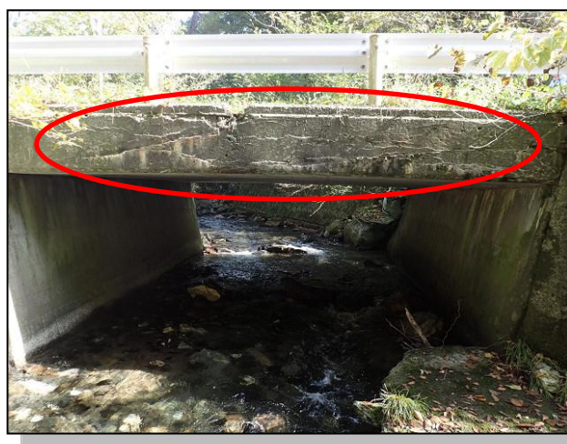
図3-5 凍害による損傷事例
