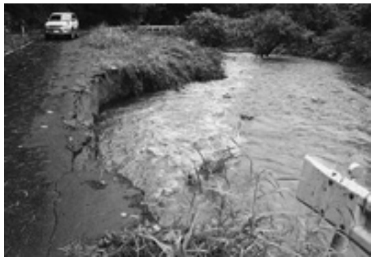
金山沢の芦間沢川が増水し、金山沢・平内線の路肩が大きく崩れた
