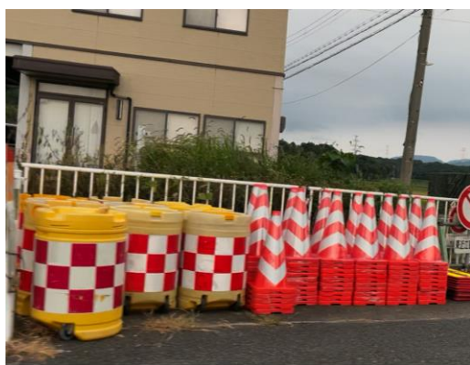
コースに接続する入口にコーン・コーンバー、クッションドラム等を設置。
