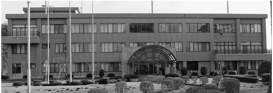
耐震補強・改修をする役場庁舎
