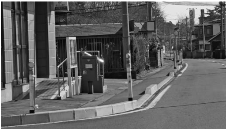
ガードレールの設置が望まれる歩道
