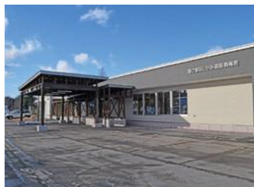
完成した道の駅はしかみ道路情報館
