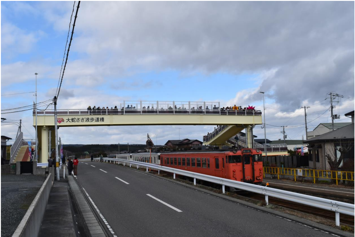
【歩道橋整備後】
