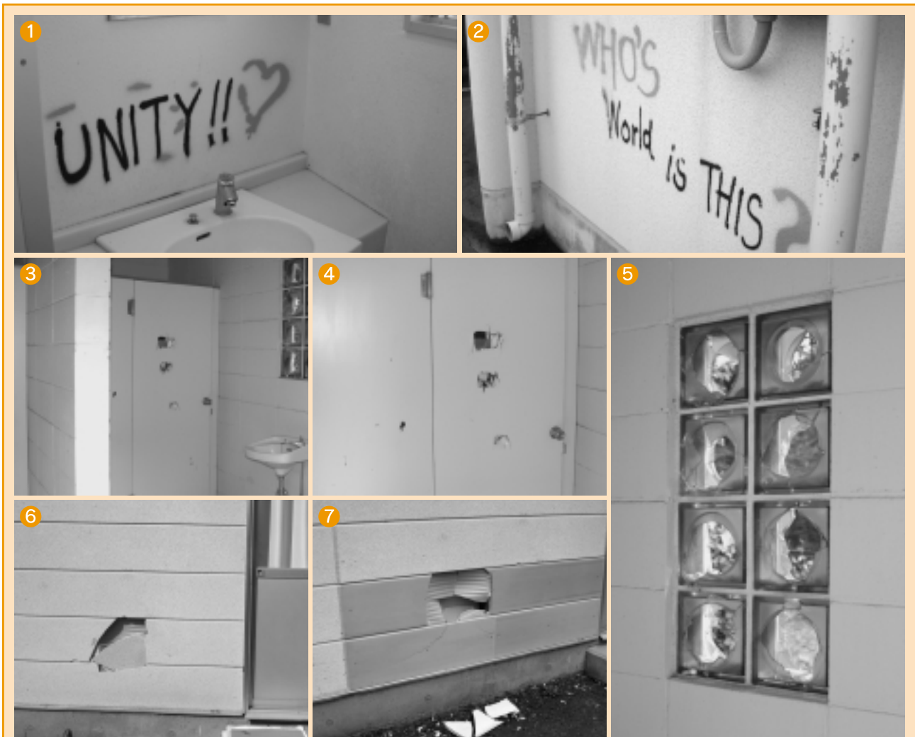
①、②：大蛇さわやかトイレの落書きの様子。③、④、⑤：蒼前集会所裏のトイレの破壊の様子。③→外観。 ④→殴られたようである。⑤→かなり厚いガラスなのだが…。⑥、⑦：蒼前集会所外壁破壊の様子。⑦→1度直したものが再び壊された。色の付いているところが補修した部分。
