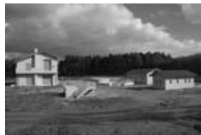
建設が進む茨島浄化センター
