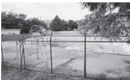
階上中学校プール
