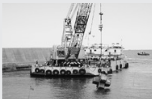
大蛇漁港内の消波ブロックの撤去作業 (6月15日)
