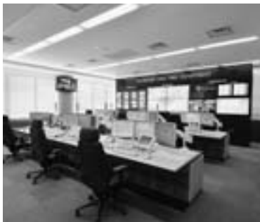
高機能消防指令センター
