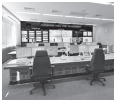
高機能消防指令センター
