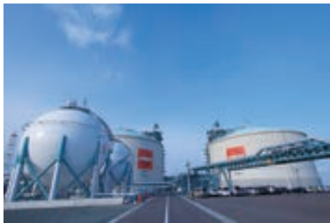
LNGターミナル
